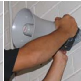
Step 5 Snap-fit horn onto Wurli-Gig.
